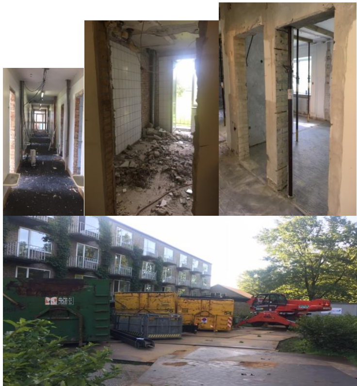
Renoveringen af Kollegium 1
